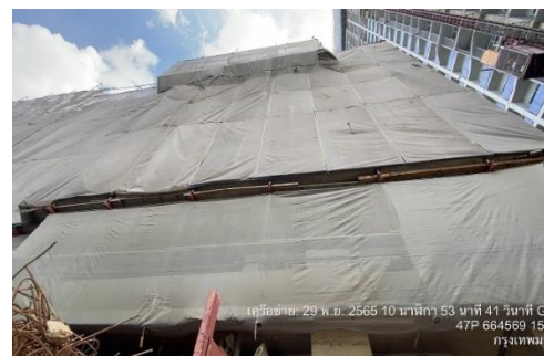
รูปที่ 38 ผ้าใบ (Mesh Sheet) คลุมโดยรอบตัวอาคาร (ปัจจุบันรื้อถอนเรียบร้อยแล้ว)
