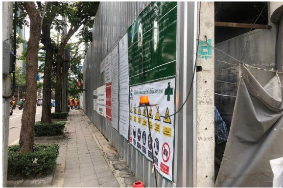
รูปที่ 16 รั้ว Metal Sheet สูง 6 เมตร
