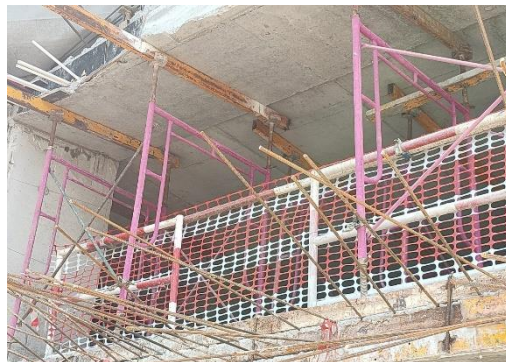
รูปที่ 44 ราวกันตกจากที่สูง (ปัจจุบันรื้อถอนเรียบร้อยแล้ว)
