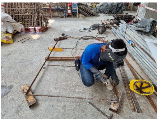
รูปที่ 43 พื้นที่เฉพาะสำหรับการเจาะ เชื่อมเหล็ก การเจียร การตัดเหล็ก
