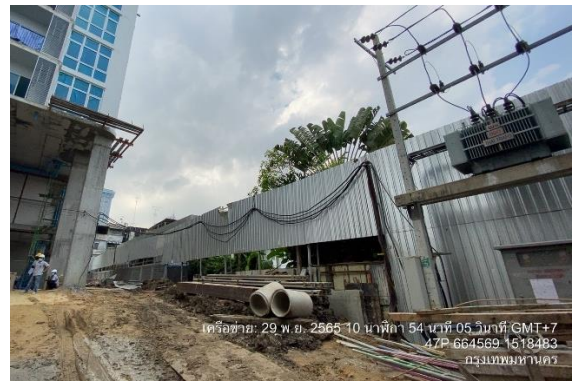
รูปที่ 16 รั้ว Metal Sheet สูง 6 เมตร
