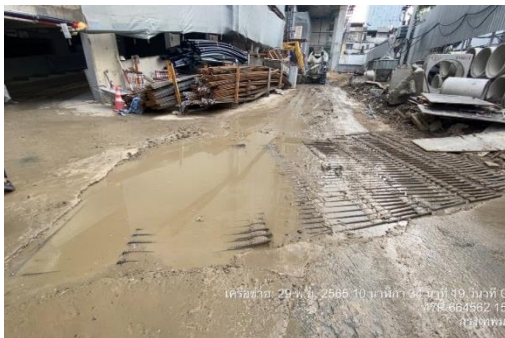
รูปที่ 18 จุดล้างล้อรถ และการทำความสะอาดล้อรถก่อนออกนอกพื้นที่โครงการ (ปัจจุบันรื้อถอนเรียบร้อยแล้ว)
